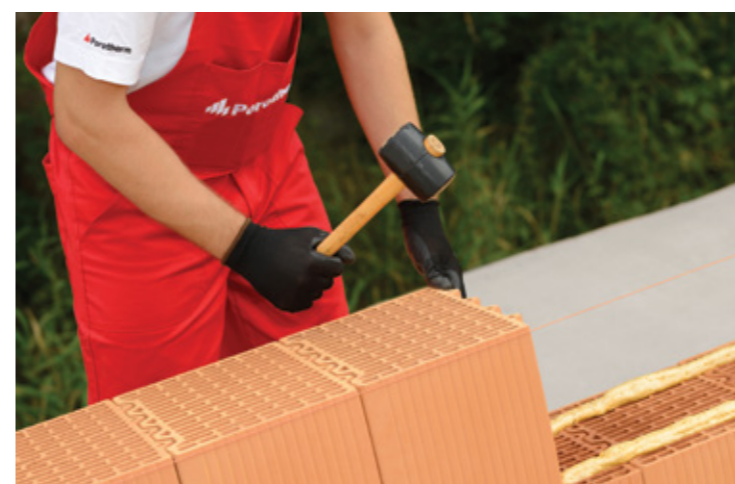
11 Se fixează următoarele blocuri ceramice cu ajutorul ciocanului de zidărie.
