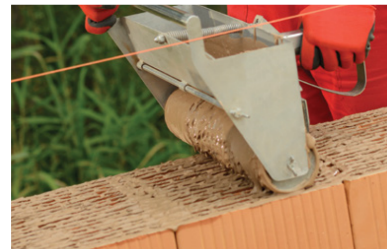
8 Grosimea stratului de mortar va fi de 1 mm.
