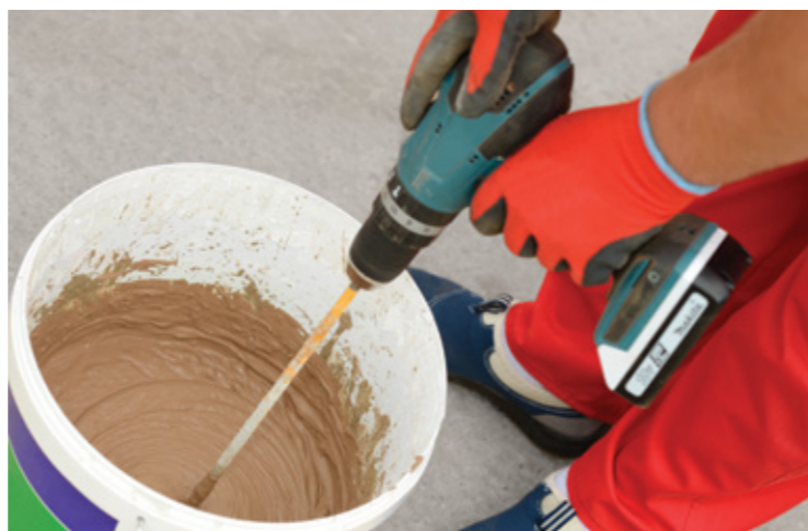
6 Se realizează amestecul de mortar Porotherm Profi în rost subțire cu apă, respectând indicațiile de pe ambalaj.
