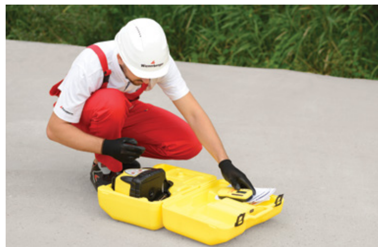
2 Se verifică planeitatea plăcii de beton cu ajutorul unei nivele laser.
