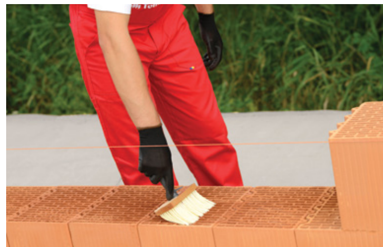
5 Se curăță de praf și se umezește rândul de cărămidă Porotherm Profi așezat anterior.
