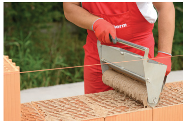
7 Se aplică mortarul Porotherm Profi în rost subțire cu ajutorul rolei de aplicare.
