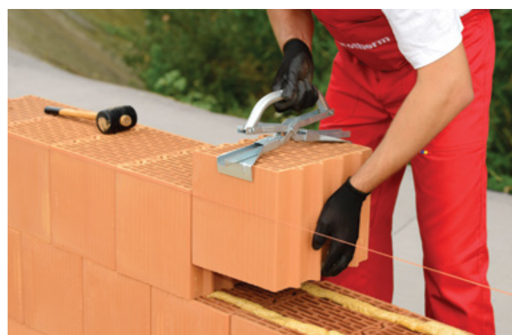
10 În maxim 2 minute de la aplicarea spumei se pun blocurile ceramice.
