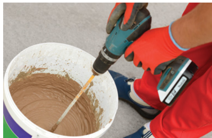
6 Se realizează amestecul de mortar Porotherm Profi în rost subțire cu apă, respectând indicațiile de pe ambalaj.
