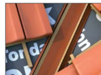
19 20 Element dolie și garnitură autoaderentă dolie
