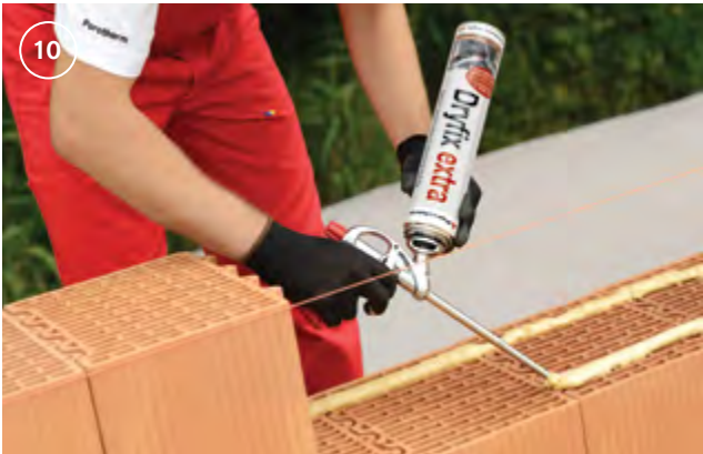
Se aplică două cordoane de spumă Porotherm Profi Dryfix extra pe o distanță de maxim 1 - 1,5 m.
