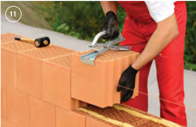
În maxim 2 minute de la aplicarea spumei se așază blocurile ceramice.
