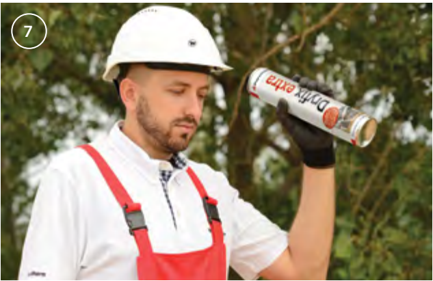
Se agită spuma Porotherm Profi Dryfix extra de 20 de ori.
