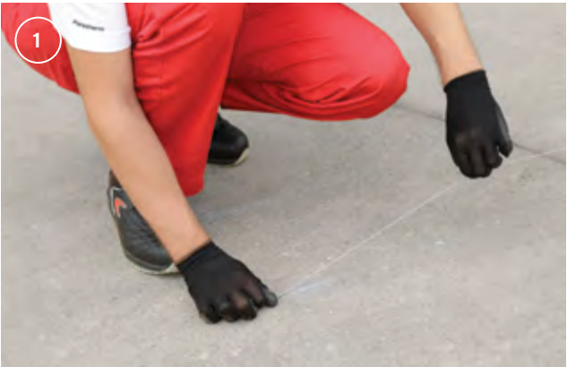
Se trasează conturul peretelui care urmează a fi zidit.
