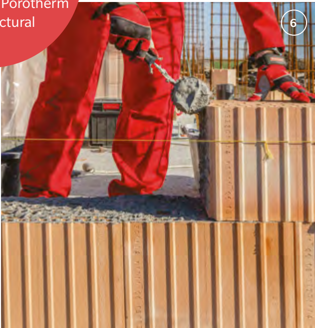
6 Grosimea stratului de mortar va fi de 1 mm. Se aplică și vertical în lăcașul de mortar.
