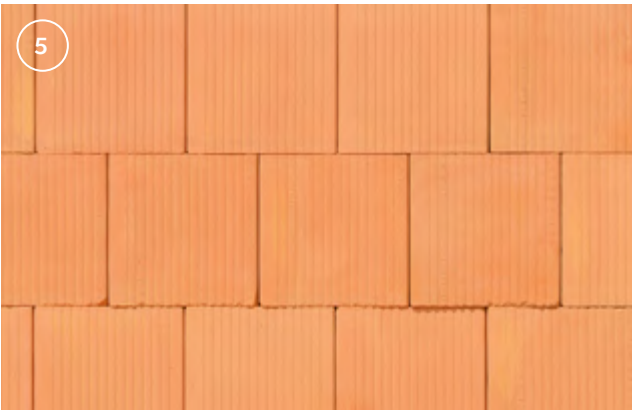
La așezarea blocurilor ceramice este important ca toate să aibă ștampila orientată pe aceeași parte*
