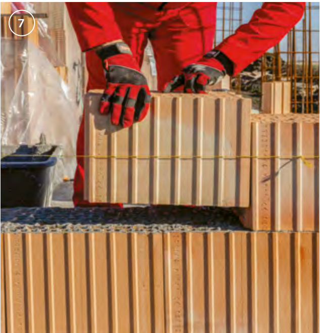
7 La așezarea blocurilor ceramice este important ca toate să aibă ștampila orientată pe aceeași parte*
