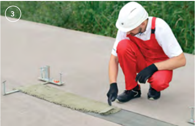
Se nivelează primul strat de mortar, preluând din denivelările plăcii.
