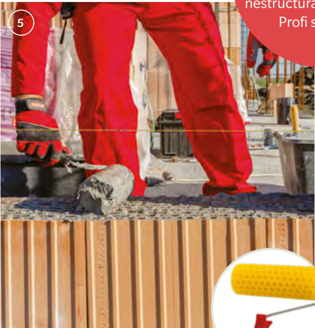
5 Se aplică mortarul Porotherm Profi în rost subțire cu ajutorul rolei de aplicare.
