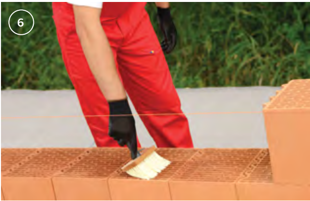
Se curăță de praf și se umezește rândul de cărămidă Porotherm Profi așezat anterior.
