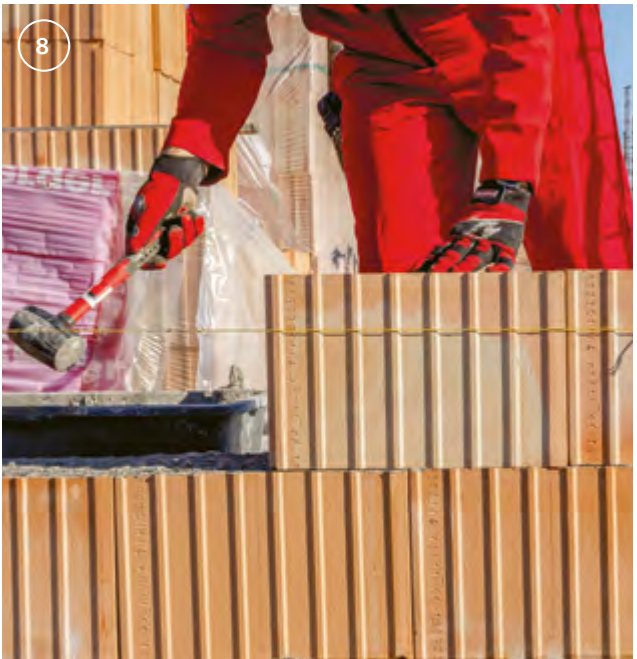
8 Se fixează următoarele blocuri ceramice cu ajutorul ciocanului de zidărie.
