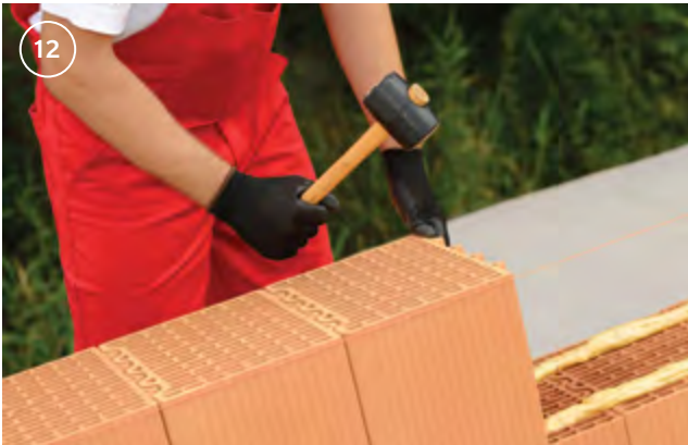
Se fixează următoarele blocuri ceramice cu ajutorul ciocanului de zidărie.
