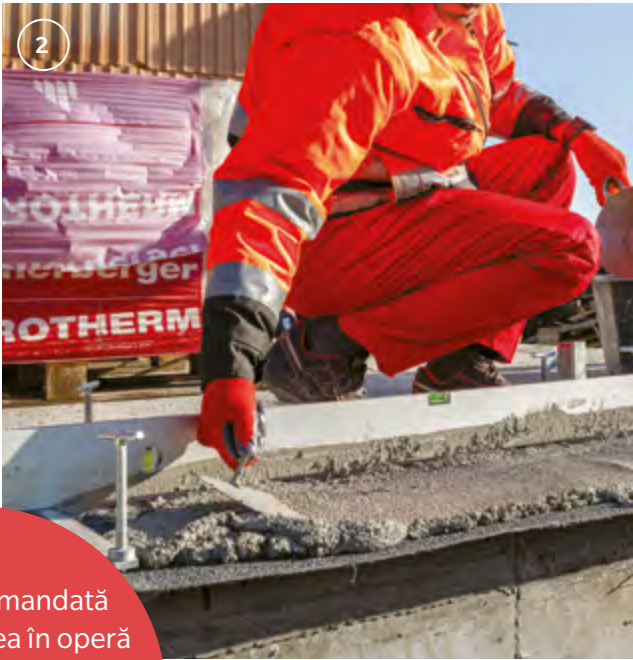
2 Se nivelează primul strat de mortar, preluând din denivelările plăcii.
