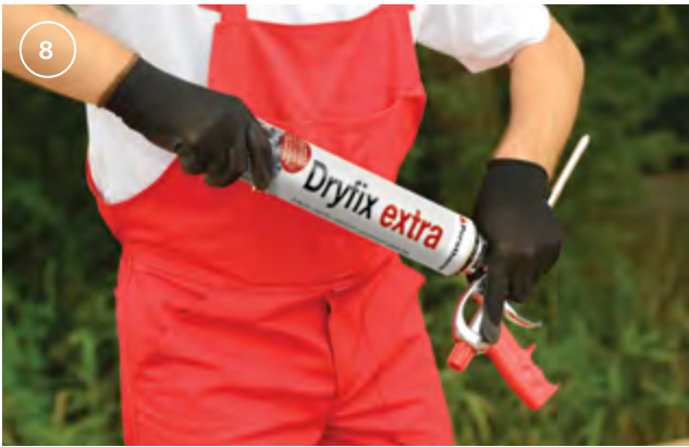
Se montează pistolul pentru aplicarea spumei Porotherm Profi Dryfix extra.
