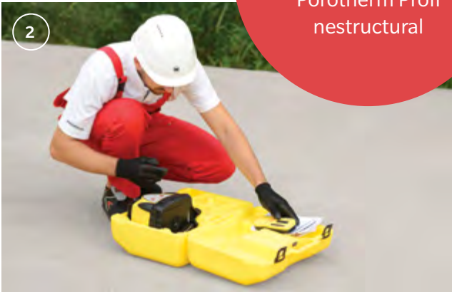
Se verifică planeitatea plăcii de beton cu ajutorul unei nivele laser.
