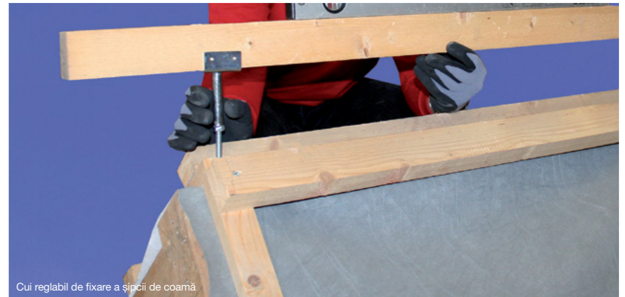
Cui reglabil de fixare a șipcii de coamă
