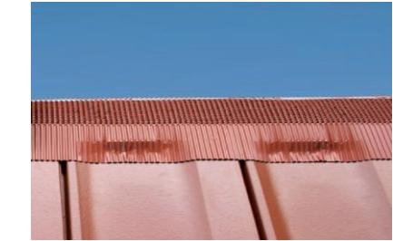
Banda de ventilare se montează cu o suprapunere de 5 cm. Suprafața pe care se aplică banda de ventilare coama trebuie să fie uscată și curată.
