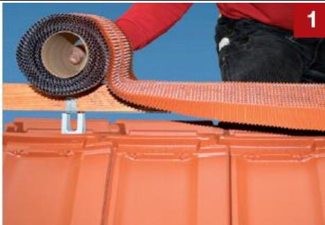
Banda de ventilare se asaza centrata pe sipca de coama a acoperisului. Apoi, banda trebuie fixata pe sipca de coama la distante de cca. 30 cm, folosind capse pentru constructii sau cuie pentru acoperis.
