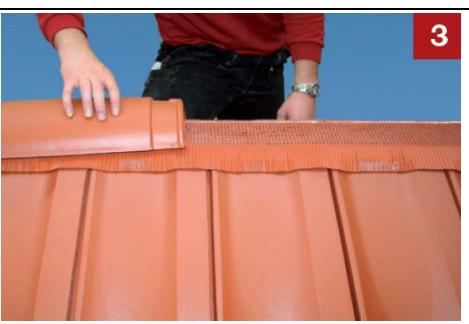
Banda de ventilare coama se fixează prin intermediul benzilor aderente pornind de sus în jos, presând secțiune cu secțiune pe tigile acoperisului. În același timp, se netezesc pliurile, începând de la marginea superioară a tigliei către marginea inferioară acesteia (de sus în jos). Surplusul de material care ramane la capatul coamei se poate taia folosind un cutit sau o foarfecă și poate fi folosit pentru urmatorul acoperis.
