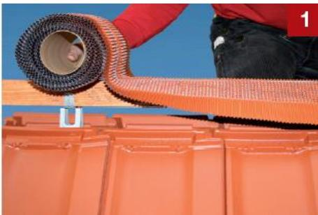
Banda de ventilare se asaza centrat pe sipca de coama a acoperisului. Apoi, banda trebuie fixata pe sipca de coama la distante de cca. 30 cm, folosind capse pentru constructii sau cuie pentru acoperis.
