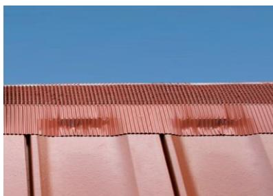
Banda de ventilare se montează cu o suprapunere de 5 cm. Suprafața pe care se aplică banda de ventilare coama trebuie să fie uscată și curată.
