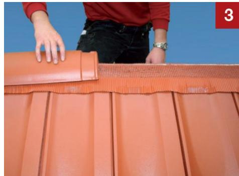
Banda de ventilare coama se fixează prin intermediul benzilor aderente pornind de sus în jos, presând secțiune cu secțiune pe tigile acoperisului. În același timp, se netezesc pliurile, începând de la marginea superioară a tiglei către marginea inferioară acesteia (de sus în jos). Surplusul de material care ramane la capatul coamei se poate taia folosind un cutit sau o foarfeca și poate fi folosit pentru urmatorul acoperis.
