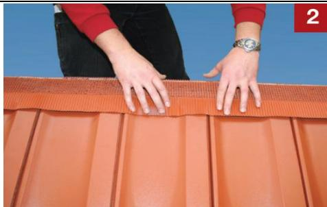
Banda de ventilare se aplică pe sipca de coama și se presează în formă de cupola.
