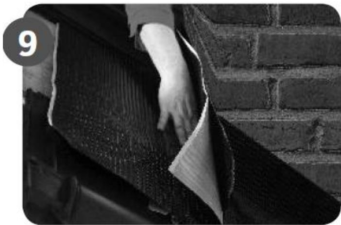
Latimea benzii de etansare din aceasta zona depinde de latimea benzii de etansare folosita pentru partile laterale ale cosului de fum.
