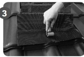
Se fixeaza partea inferioara a benzii de etansare (cea in contact cu tiglele ceramice) prin presare cu o rolă de nivelare mai intai in punctele cele mai inalte ale tiglei si apoi in zonele plane ale acesteia.
