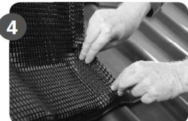
Portiunea de banda extra (4 cm) se indoiește pentru a crea suport in vederea lipirii benzii de etansare folosita pentru fetele laterale ale cosului de fum.
