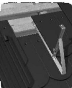
Montati un nou rand de tigla pe acoperis (folositi tigla de tip solzi ajustata la margini).
