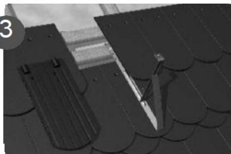
Montati tigile de tip solzi langa elementele suport ale sistemului de parazapada.
