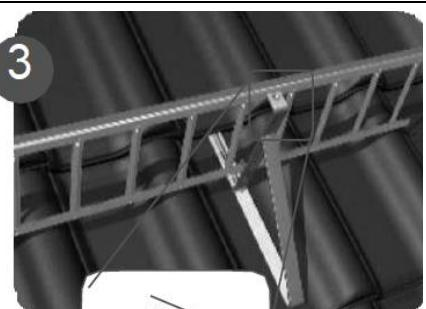
Agatati/ inserati grilajul sistemului de parazapada de elementele suport deja montate.
