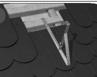
Montati tigla de tip solzi pe acoperis pana la pozitia de fixare dorita a suportilor sistemului de parazapada.
