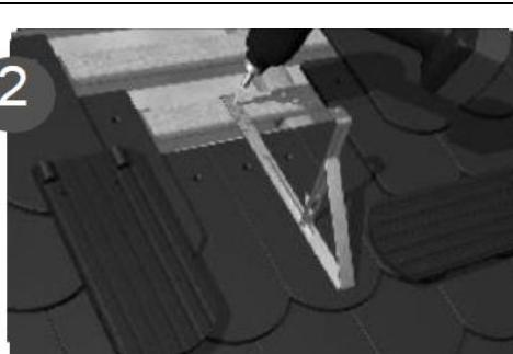
Fixati elementele suport ale sistemului de parazapada de sipca de sustinere folosind 2 suruburi pentru lemn protejate impotriva coroziei.
