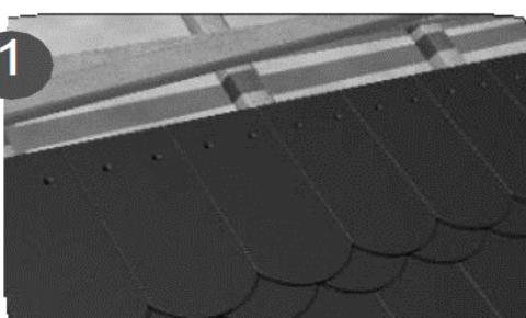
Montati tigla de tip solzi pe acoperis pana la pozitia de fixare dorita a suportilor sistemului de parazapada.
