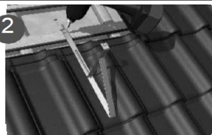
Fixati elementele suport ale sistemului de parazapada pe sipca de sustinere folosind 2 suruburi pentru lemn protejate impotriva coroziei.
